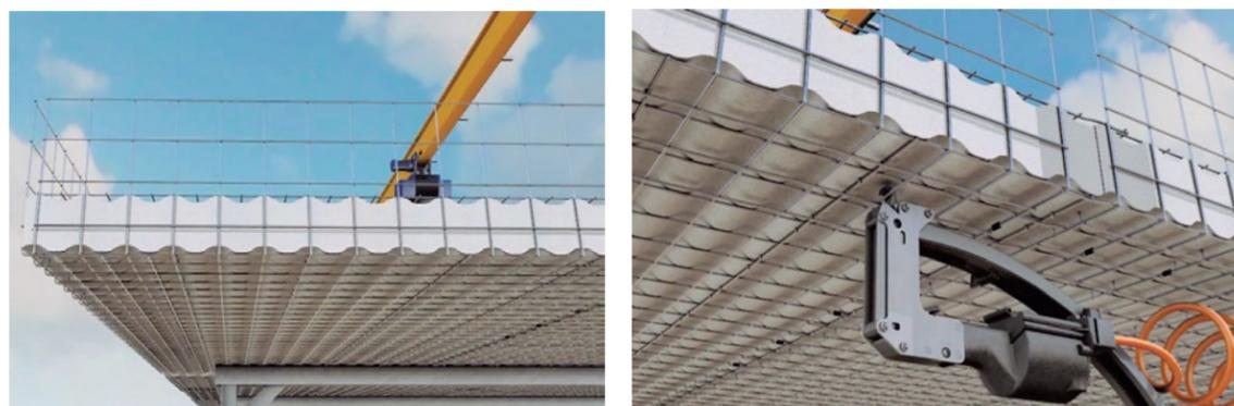
**Figura No.21:** Malla de refuerzo angular para unión de muro con muro y muro con losa.
