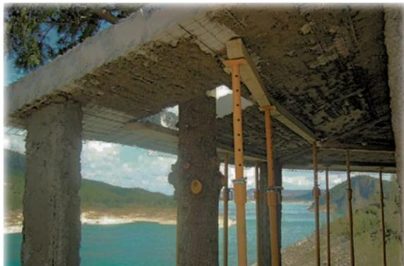
Figura No.42: Elementos de apoyo para restringir desplazamientos verticales al momento del colado de la losa.
