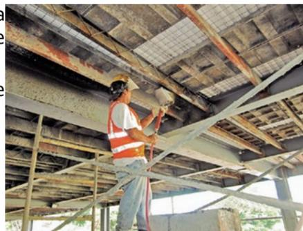
Figura No.25: Proceso de revoque de capa inferior losas estructurales paneles EMMEDUE.
