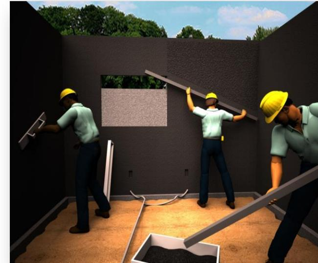
**PASO 4.** Una vez que terminamos la aplicación de repello debemos mantener la humedad constante en la capa de repello durante los próximos 15 días como mínimo.
