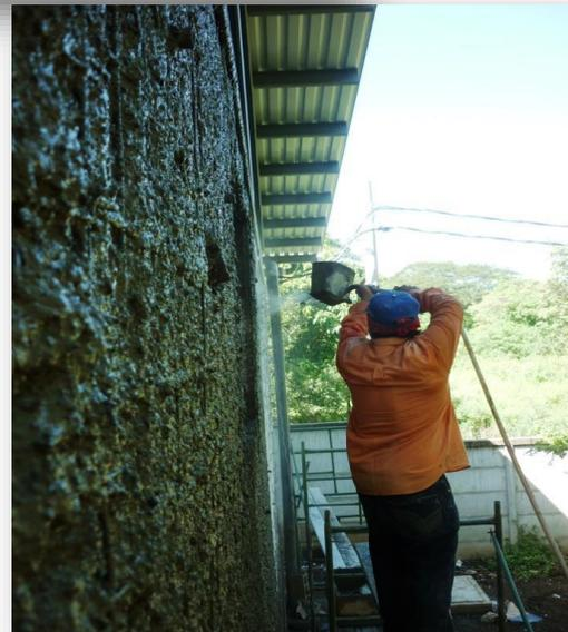
En este punto es importante que el operador de la revocadora mantenga un balde con agua a la par para que cada cinco lanzadas limpie la herramienta y el proceso de lanzado no se interrumpa por obstrucción en los ductos de salida.
