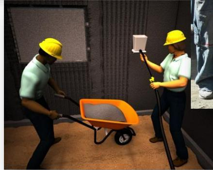
**PASO 2.** la aplicación debe ser a una velocidad que con el flujo de mezcla vaya recubriendo parcialmente la malla.
