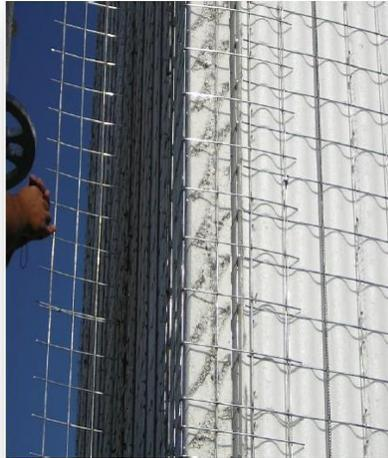
Malla plana de refuerzo en aberturas ambos lados del panel electrosoldada de acero galvanizado de  $\varnothing 2.4\text{mm}$  fijada con grapas o amarrada con alambre #18
